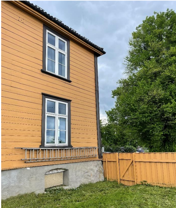
Fig. Foto av eksisterende kjeller vindu (2 stk.)
