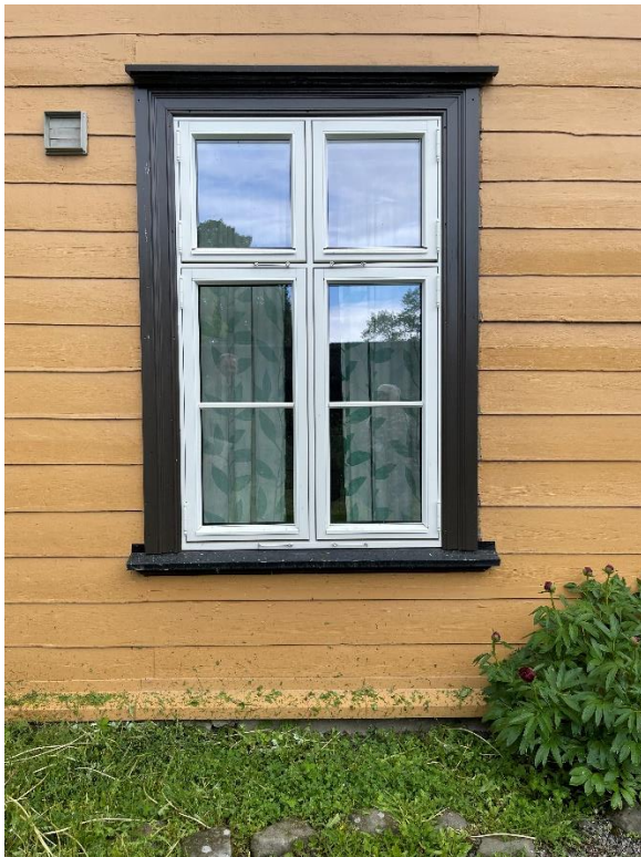
Fig. Foto av eksisterende vinduer. YV1 – byttes 2 stk. til EI30 vindu. YV2 – vindu i plan 2 byttes til EI30 vindu
