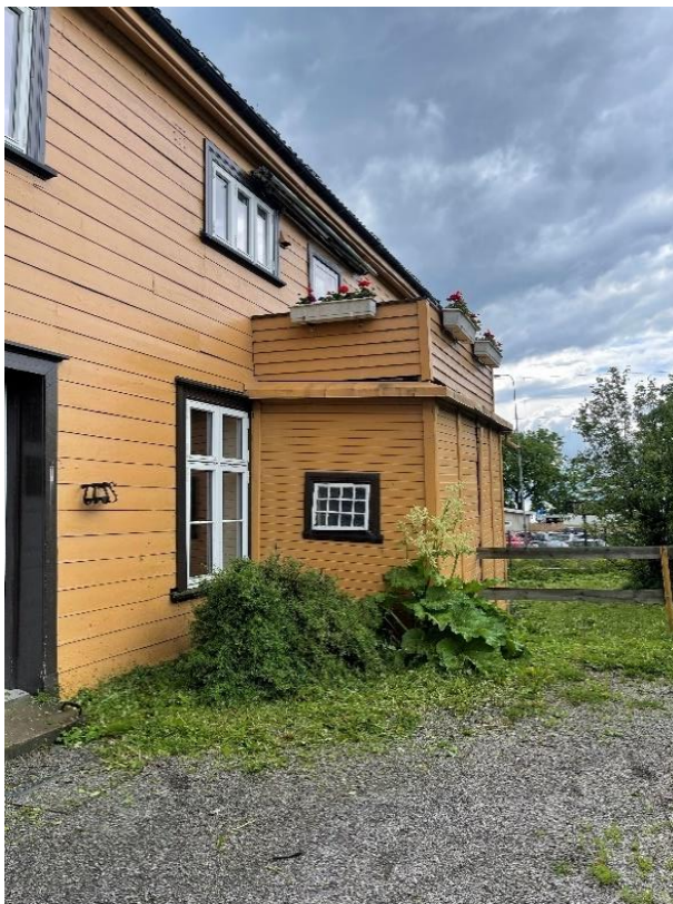
Fig. Foto av det eksisterende tilbygget.
