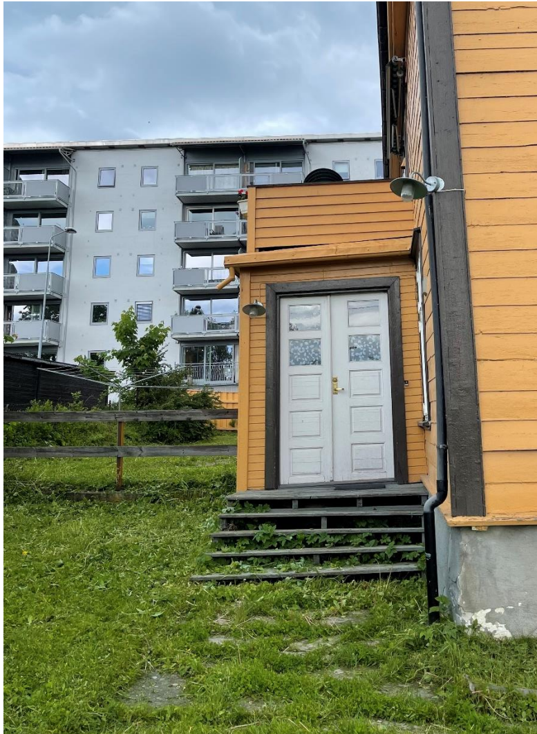
Fig. Foto av eksisterende ytterdører.
