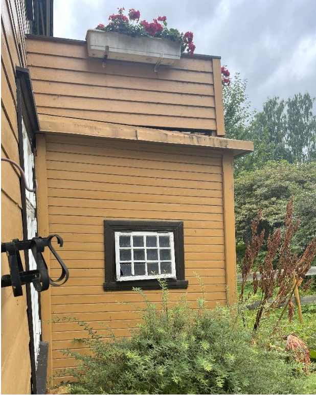
Fig. Foto av eksisterende vinduer YV 3 – Fast vindu i tilbygg skal tilfredsstillende brannkrav. Vurderes tett innvendig.
