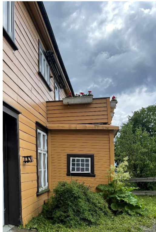
Fig. Foto av eksisterende vinduer. YV1 – byttes 2 stk. til EI30 vindu. YV2 – vindu i plan 2 byttes til EI30 vindu
